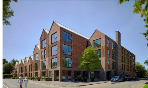
Verschillende bouwhoogtes binnen één bouwblok
