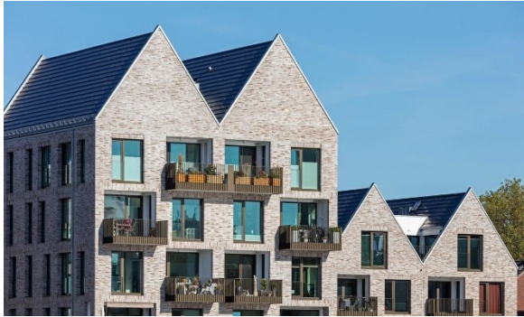
Afwisseling in hoogte van bouwvolumes.
